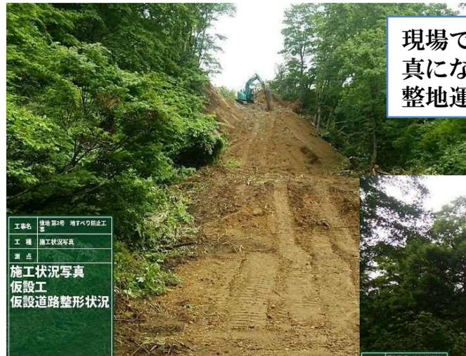
現場での仮設道路整形状況の写真になります。バックホウと不整地運搬車で作業しています。
