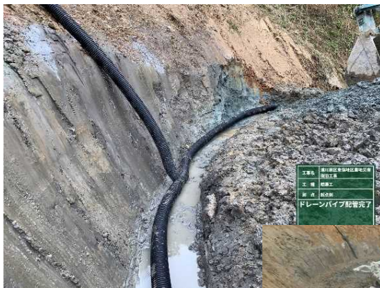
暗渠工 施工状況
