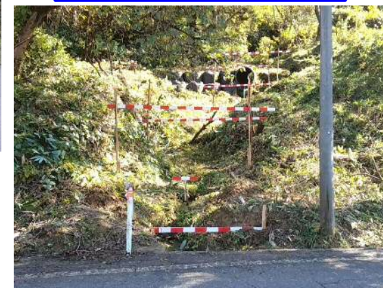
丁張り設置完了
