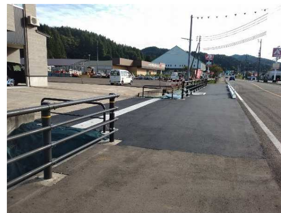
起点側より撮影
