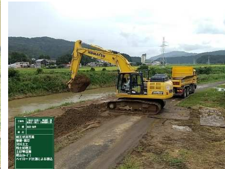
ICT建機による積込状況
