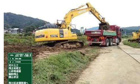
ICT建機による積込状況
