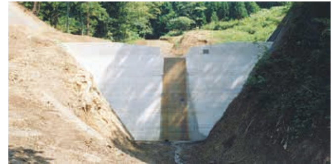
地すべり防止（溪流）工事 浦川原村谷地内
