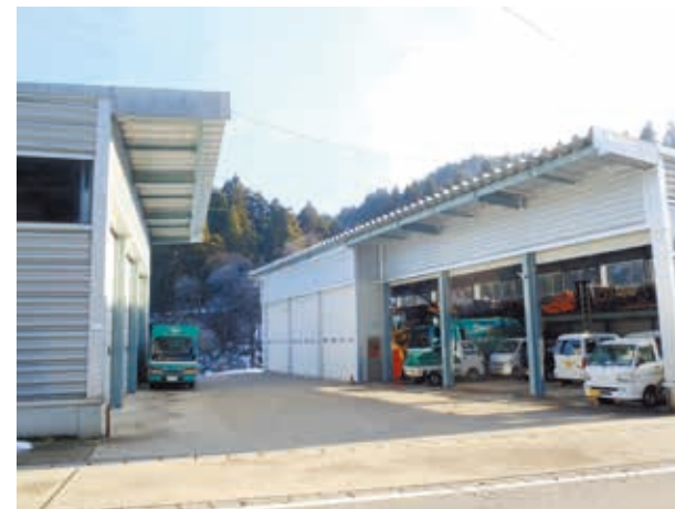
横住格納庫 NO1,2 用途：環境関連車両・除雪車車庫 所在地：上越市浦川原区横住 395-1 建設年：平成 13 年新築 構造・面積：NO1 鉄骨平屋建て 161.50㎡ NO2 鉄骨平屋建て 265.45㎡ 敷地面積 約 2,637㎡
