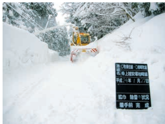
ロータリー除雪車作業状況
