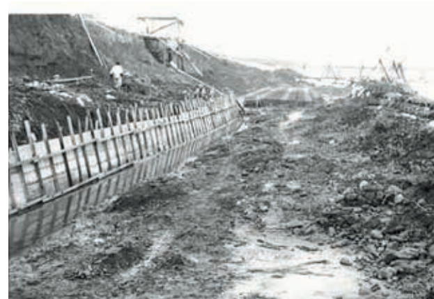
保倉川横川施工中
