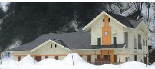
安塚地区・須川地区農業集落排水処理場運転・維持管理
