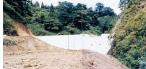
発注者：上越林業事務所 工事番号：予第 15 号 工事名：予防治山工事 工事場所：東頸城郡浦川原村大字東俣地内 工期：S 57.4.28－S57.11.3 請負金額：13,343,000 担当者：梅澤隆昭 工事概要：コンクリート 谷止工 L=29.5m H=7.0m V=395.2m3 現場の思い出：左岸間詰め型枠がパンクし、印内防火水槽班から応援してもらう。
