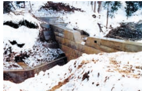
発注者：安塚土木事務所 工事番号：58 災第 269 号 工事名：円行寺川砂防災害復旧工事 工事場所：東頸城郡浦川原村大字追出地内 工期：S 58.8.12－S58.12.29 請負金額：36,294,000 担当者：藤村勝久 工事概要：コンクリート堰堤工、本堤工 653.2㎡ 前提工 67.2㎡、側壁 44.0㎡、 水叩コンクリート 34.3㎡、水叩間詰工 132.2㎡ 現場の思い出：1.0㎡バケットを吊れる索道を張る。 初めて K 4（3 t 吊）ウインチを買う。ヤンマー 110 エンジン中古（5 万）で大越氏より買う。 12 月 3 日にコンクリートバケットを落下させる。 大事故の一手手前で済む。
