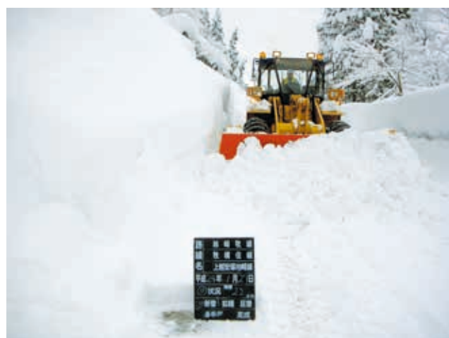
除雪ドーザ作業状況
