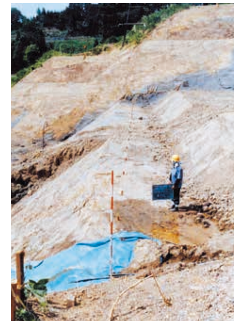
発注者：東頸農地事務所 工事番号：58 災 5220-8002 工事名：追出地区農地保全工事 請負金額：12,808,000 担当者：藤村勝久 工期：S 59.3.7－S59.11.11 工事概要：農地保全工 一式 現場の思い出：杭打工 2 線＋増工で 1 線施工する。 グラウトに苦しむ。 THS70 ボーリングマシンの新品を購入。 1 台は保坂組から借用。
