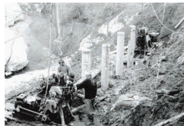
S42-9 谷パイル打ち
