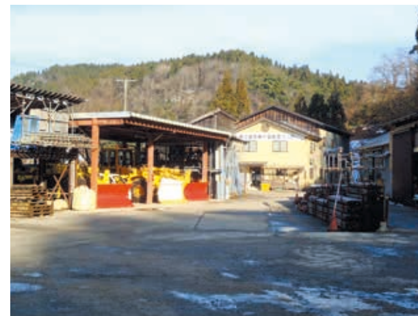
杉坪倉庫・除雪センター 用途：土木資材倉庫・除雪センター 所在地：上越市浦川原区杉坪 59-2 建設年：昭和 57 年新築、平成 13 年増改築 構造・面積：木造 2 階建て 540.40㎡ 敷地面積 約 4,496㎡
