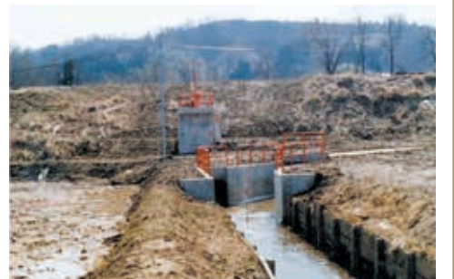
発注者：東頸農地事務所 工事番号：老朽ため池整備事業 工事名：山本地区ため池改修第 1 次工事 工事場所：東頸城郡浦川原村大字山本地内 工期：S 53.10.14－S 54.2.10 請負金額：6,951,000 担当者：藤村博俊 工事概要：土砂吐工余水吐水路 現場の思い出：技術難度の高い工事で当社施工できるか危ぶまれたが、苦勞しながら無事終了。「技術の藤村」の先駆けとなった工事
