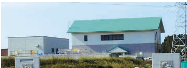
公共下水道浦川原浄化消センター運転・維持管理
