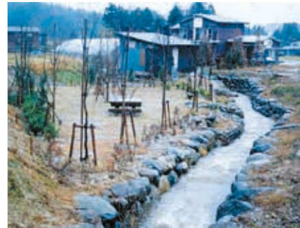
鍋立地区第 3 次工事 山本地内
