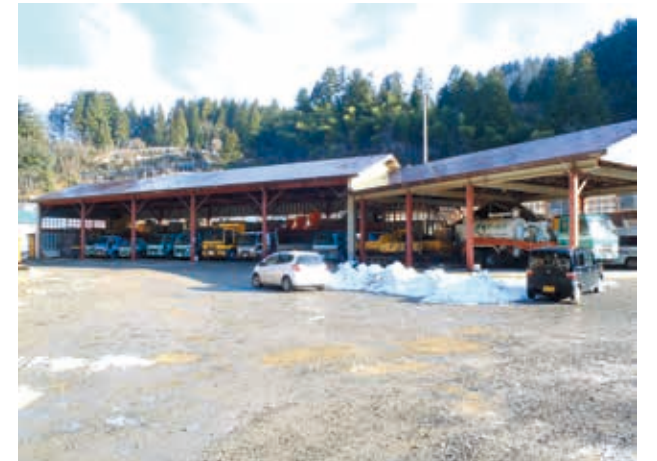
六日町車庫棟 用途：大型車両車庫・資材置場（敷地全景は右上写真） 所在地：上越市浦川原区六日町字中山 550-1 他 建設年：平成 14 年新築 構造・面積：鉄骨造平屋建て 347.62㎡
