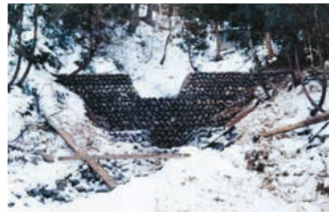
発注者：安塚土木事務所 工事番号：単地第 1401 号 工事名：荒牧地すべり地すべり防止工事 工事場所：東頸城郡浦川原村大字法定寺地内 工期：S52.10.7－S52.12.16 請負金額：3,817,000 担当者：藤村勝久 現場の思い出：TDC 購入する。
